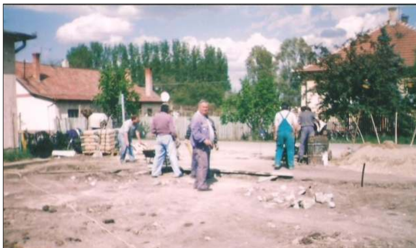
Az iskolakonyha építése a 2000-es évek elején
